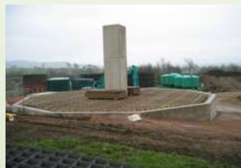
Fundament przygotowany pod budowę oczyszczalni HYRATE
