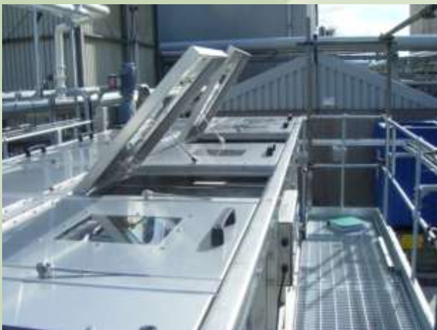
Jednostka flotacji Ciśnieniowej
