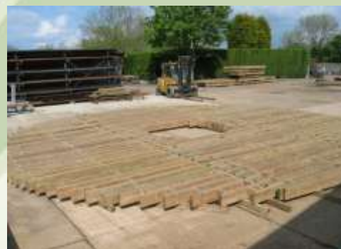
Kontrola jakości zmontowanych wstępnie elementów gotowych do transportu
