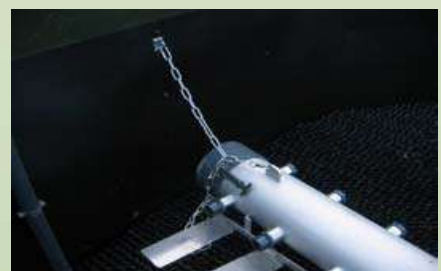
Otwór kontrolny na ramieniu zrasczacza umożliwiający szybkie przepłukanie urządzenia, łańcuch ze stali nierdzewnej
