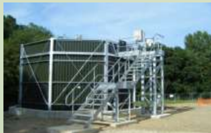
Typowa oczyszczalnia HYRATE ze schodami do złoża i panelem kontrolnym zamontowanym przy otworze rewizyjnym.
