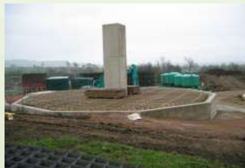
Fundament przygotowany pod budowę oczyszczalni HYRATE
