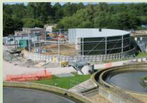
Złoże biologiczne o średnicy 25 m w budowie. Drewniany fundament służy jako pomost roboczy i miejsce składowania materiałów.
